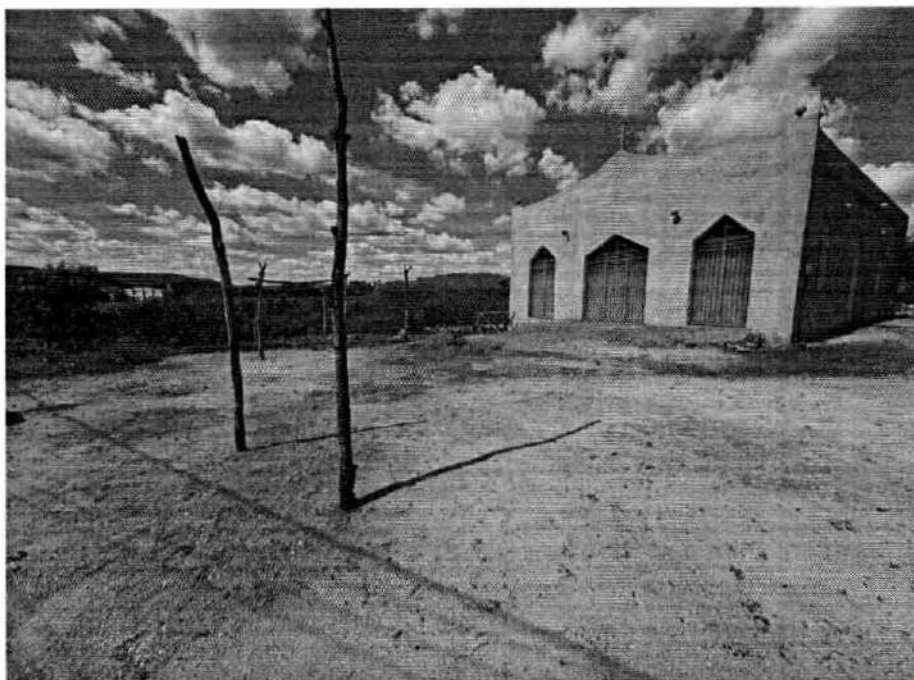
Foto 04 – Local de Construção da Praça.
