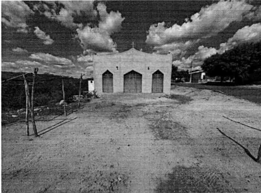
Foto 07 – Local de Construção da Praça.
