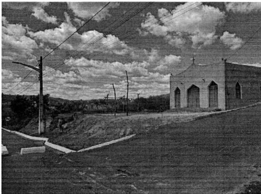
Foto 01 – Local de Construção da Praça.
